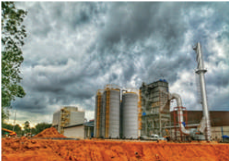
ระบบบำบัดอากาศ และระบบบำบัดน้ำ (Flue Gas Cleaning & Water Treatment)
