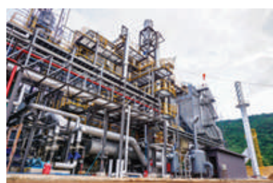
ระบบบำบัดอากาศ (Flue Gas Cleaning)
