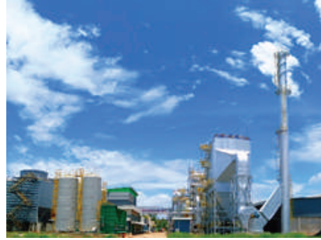
ปล่องระบาย และระบบกำจัดฝุ่น (ESP & Stack)
